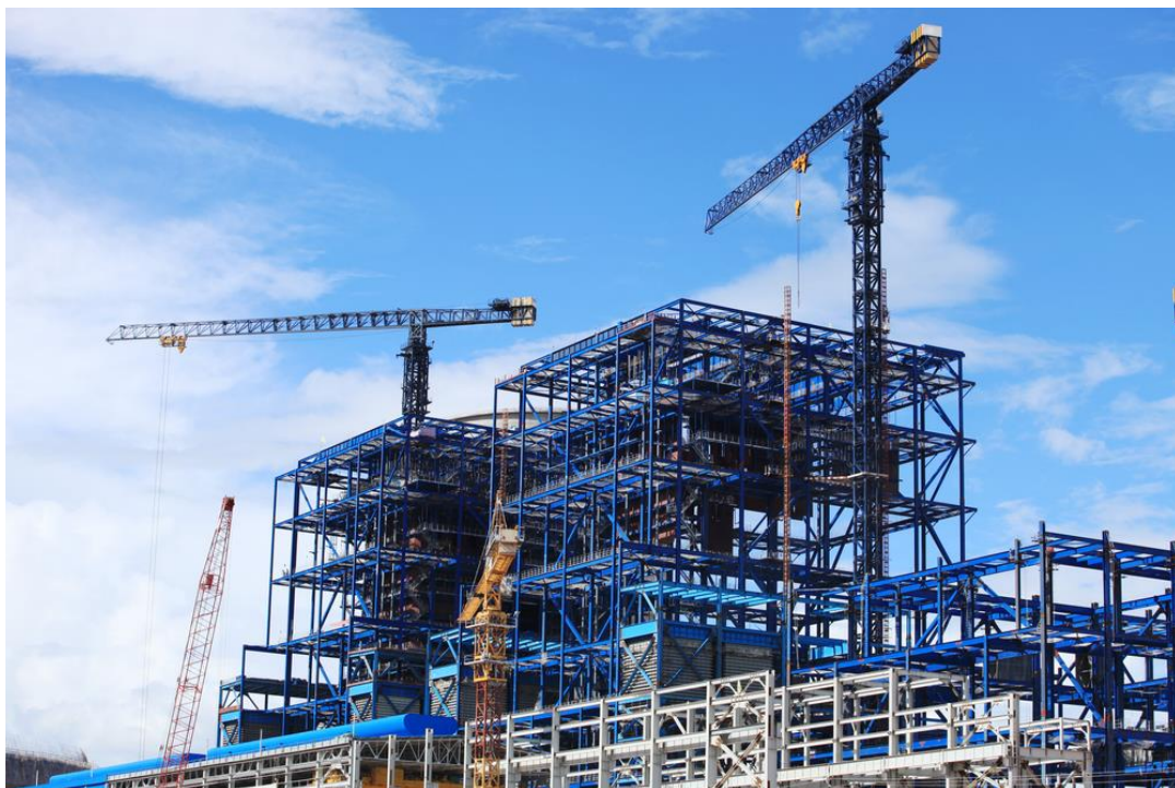
СТРОИТЕЛЬСТВО ЗДАНИЙ И СООРУЖЕНИЙ
